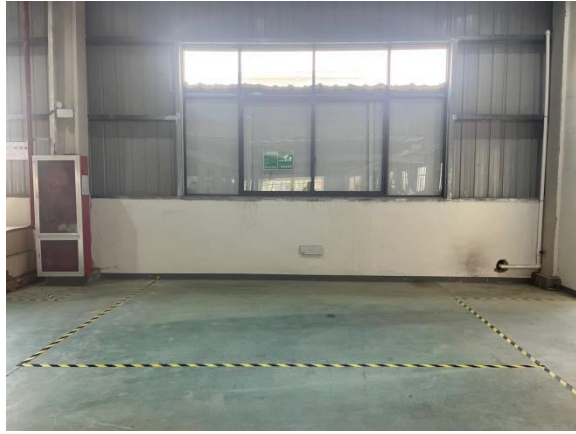
一般工业固废暂存区
